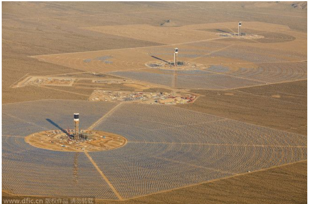
Toàn cảnh nhà máy điện mặt trời Ivanpah.
