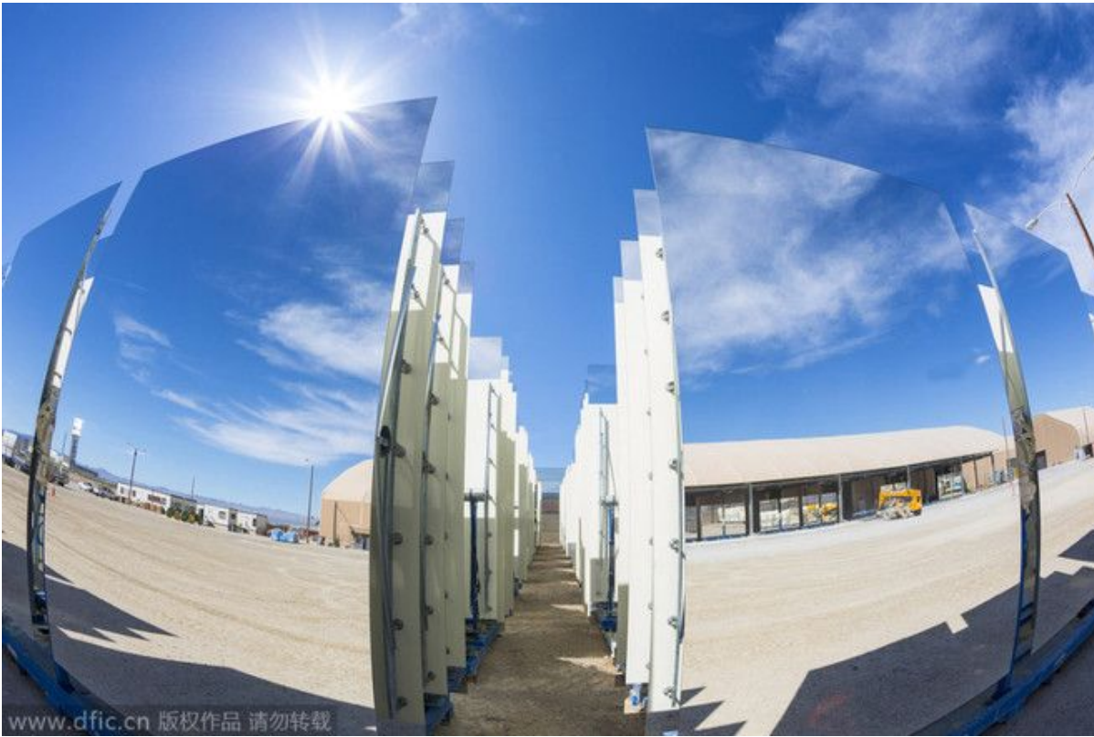
Các tấm gương thu năng lượng phản chiếu hình ảnh của nhà máy và bầu trời.
